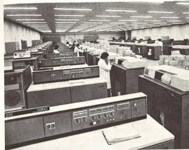
Abb. 1.2.3/4: Druckerzimmer der DATEV eG mit 30 installierten Schnelldruckern
